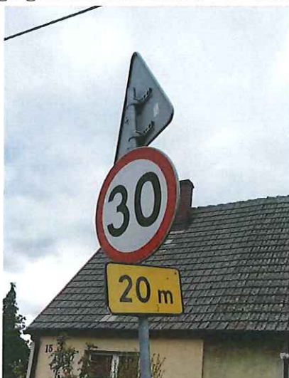
Znak drogowy A-11a „próg zwalniający”, B-33 „ograniczenie prędkości” (T-1) niewłaściwe odchylenie tarczy znaku w stosunku do osi jezdni.
