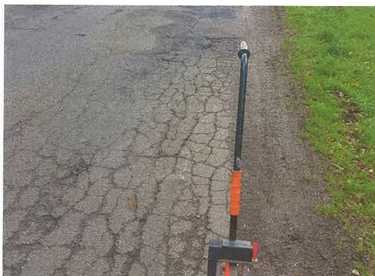
Fot. 2 Liczne uszkodzenia krawędzi jezdni
