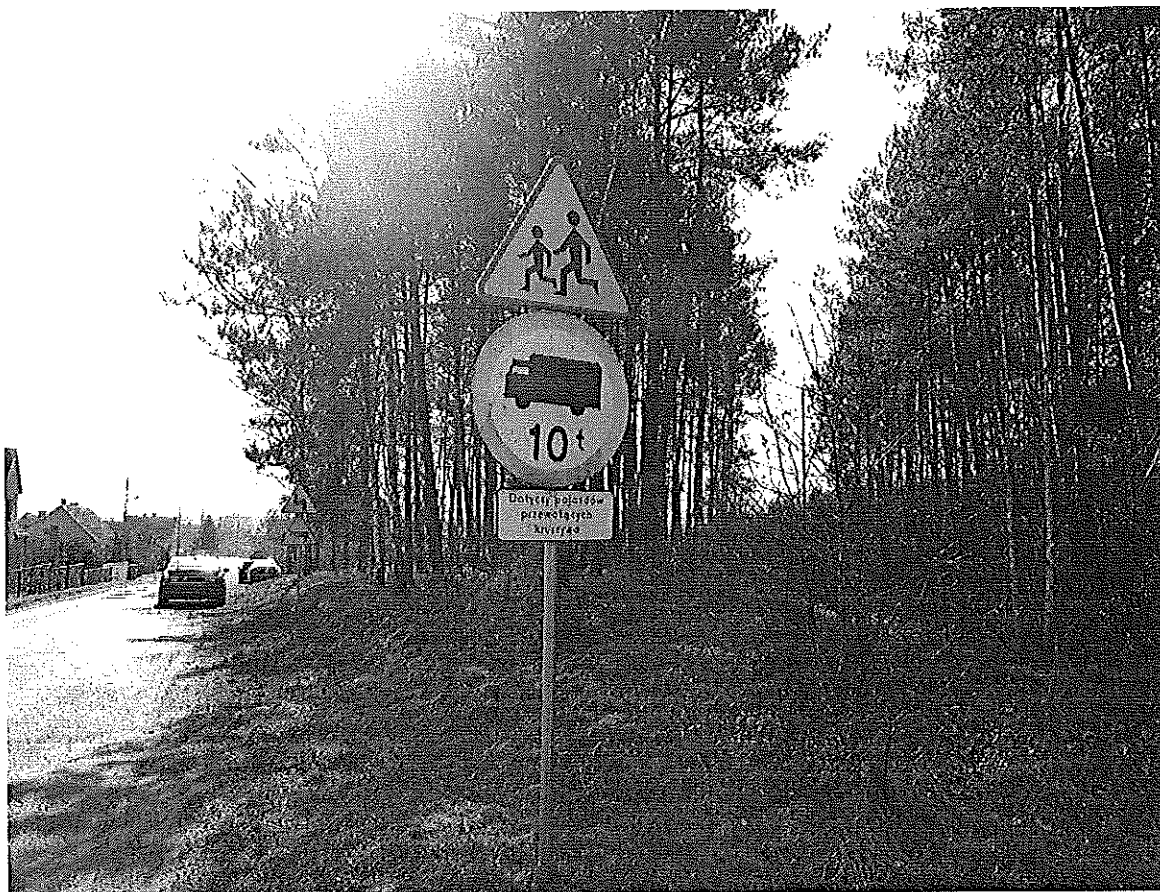
Droga powiatowa nr 4112Z, m. Stawno. Czerwona obwódka znaku B-5 wyblakła.
