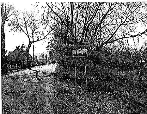
Droga powiatowa nr 4159Z, m. Kol. Czermnica Znaki E-17a oraz D-42 pocięte. Niezgodne z przepisami oznakowanie przystanku. Brak zatoki autobusowej lub linii przystankowej P-17.
