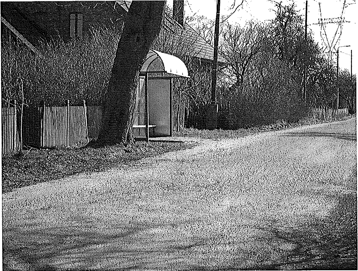
Droga powiatowa nr 4144Z, m. Dobrosławiec Czynny przystanek autobusowy z wiatą przystankową bez oznakowania pionowego D-15 oraz bez linii przystankowej P-17.
