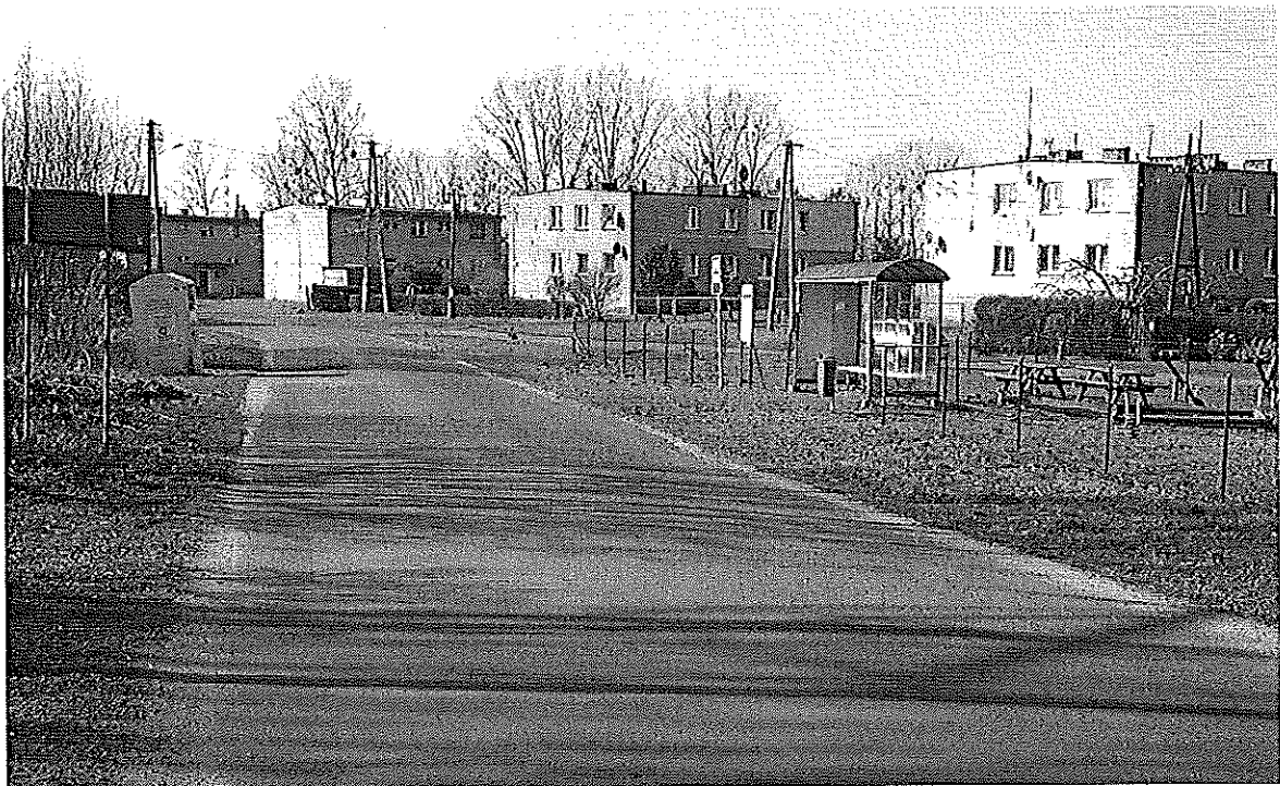
Droga powiatowa nr 4132Z, m Łoźnica - brak chodnika w miejscowości. Tarcza znaku D-15 obrócona - ustawiona równoległe do drogi. Brak zatoki autobusowej lub linii przystankowej P-17.
