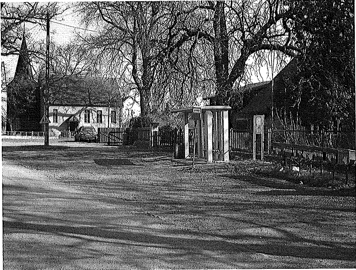
Droga powiatowa nr 4137Z m. Czermnica – skrzyżowanie z drogą powiatową nr 4160Z. Znak drogowy D-15 niezgodny z obowiązującymi przepisami. Brak wyznaczenia linii przystankowej P-17 lub zatoki autobusowej.
