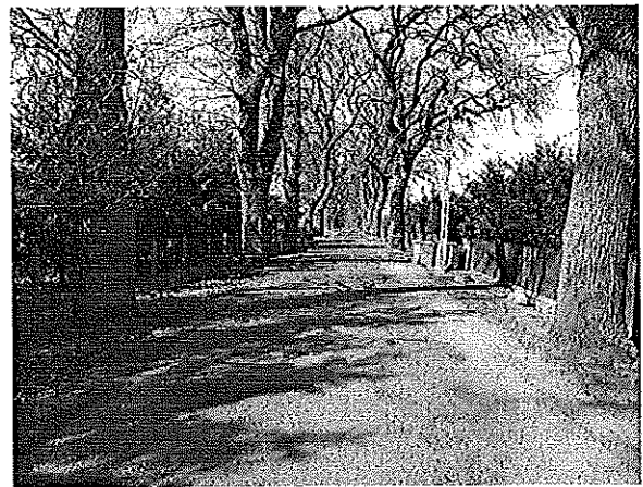
Droga powiatowa nr 4111Z, m. Tarnówko. Przystanek autobusowy oznakowany niezgodnie z obowiązującymi przepisami. Betonowa konstrukcja wsporcza znaku. Brak zatoki autobusowej lub linii przystankowej P-17. Drzewa w skrajni drogi.
