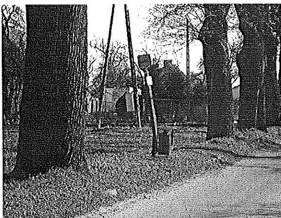
Droga powiatowa nr 4111Z, m. Tarnówko. Przystanek autobusowy oznakowany niezgodnie z obowiązującymi przepisami. Betonowa konstrukcja wsporcza znaku. Brak zatoki autobusowej lub linii przystankowej P-17. Drzewa w skrajni drogi.
