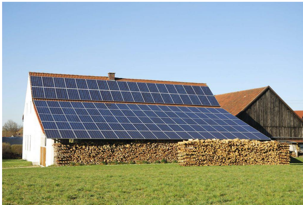
Instalacja fotowoltaiczna zlokalizowana na dachu
