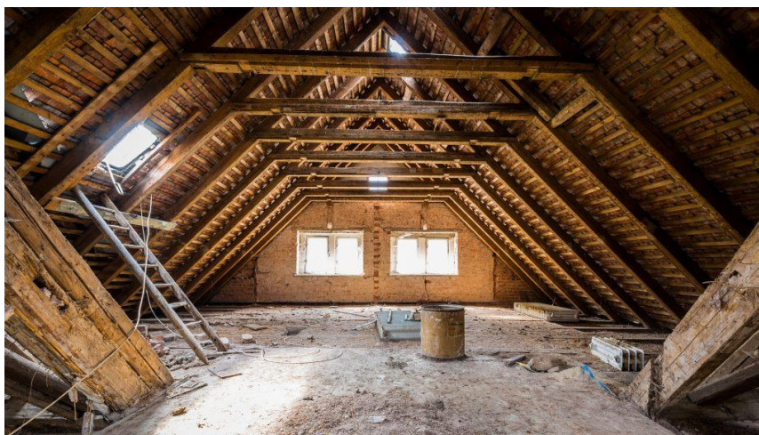
Konstrukcja drewniana budynku mieszkalnego
