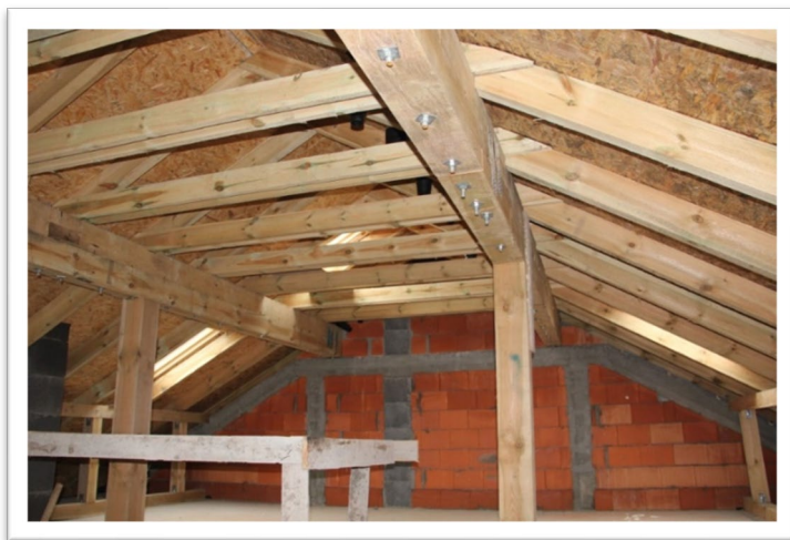
Konstrukcja drewniana budynku mieszkalnego
