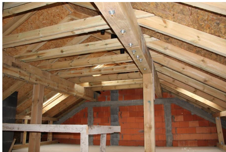
Konstrukcja drewniana budynku mieszkalnego
